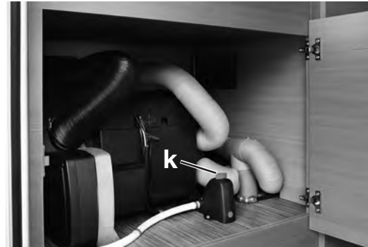
Sicherheitsventil für Boiler (FrostControl)
