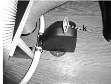
Sicherheitsventil für Boiler (FrostControl)
