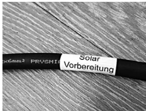
Kabel Vorbereitung Solaranlage
