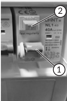
FI-Schutzschalter und Testknopf
