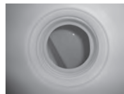
Depósito de agua limpia
