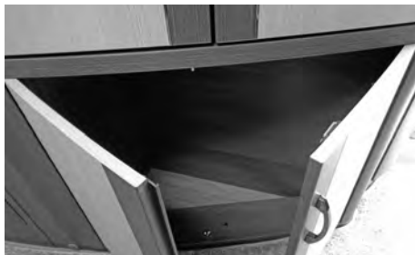
Dörr med magnetlås
