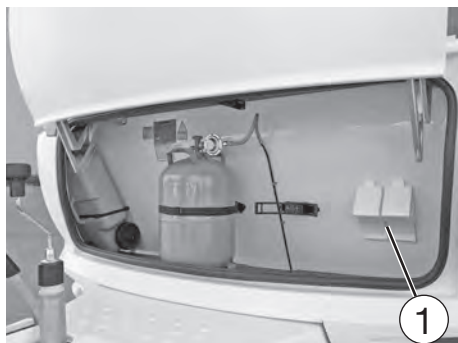
Underläggskilar i gasolkoffert
