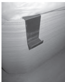
Placera fäst hållarna
